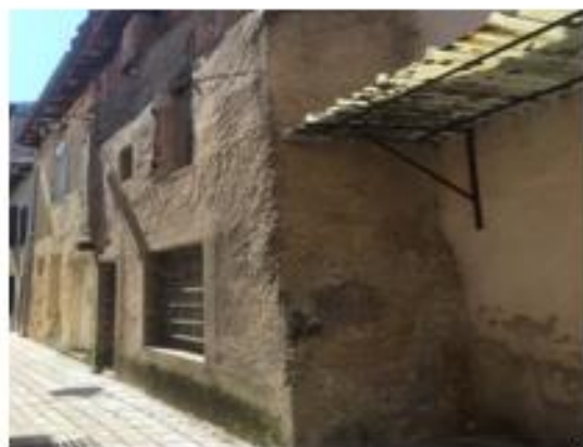
Façade arrière côté venelle
